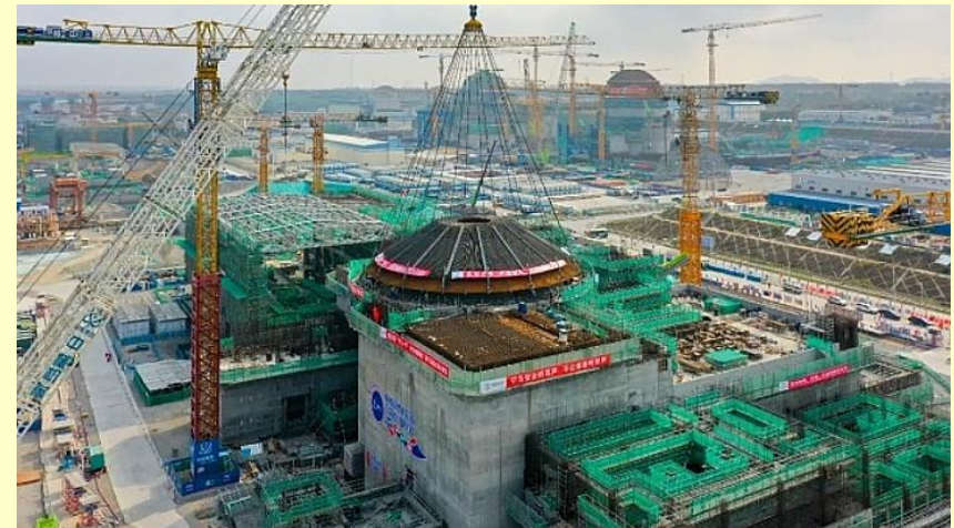
Konstrukce kontejnmentu je dokončena
