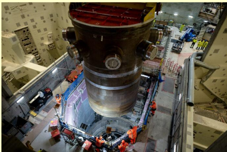
Instalace reaktorové nádoby v Hinkley Point C
